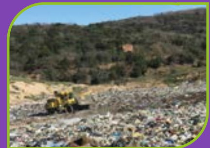
SITE DE STOCKAGE DES DÉCHETS NON DANGEREUX À SOUMONT (34)
