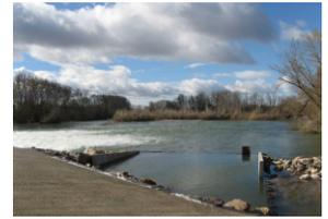
Berge érodée en rive droite de l'Hérault/ Travaux sur le seuil dans le cadre de la création de passe à poissons
